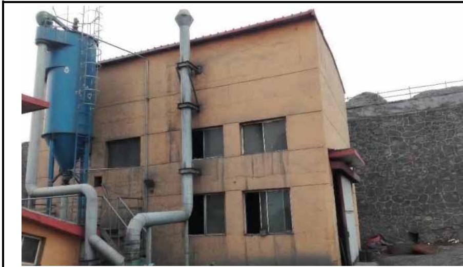
粗破碎全封闭车间
