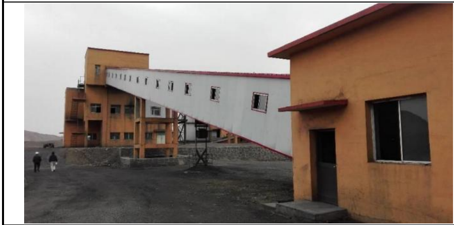
粗破碎至中细破碎全封闭输送带
