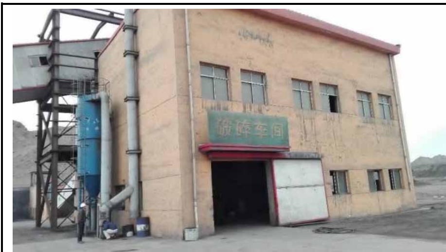
中细破碎全封闭车间
